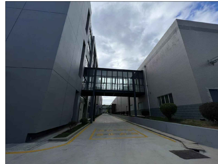
项目区现场照片4
