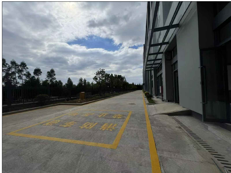
项目区现场照片3
