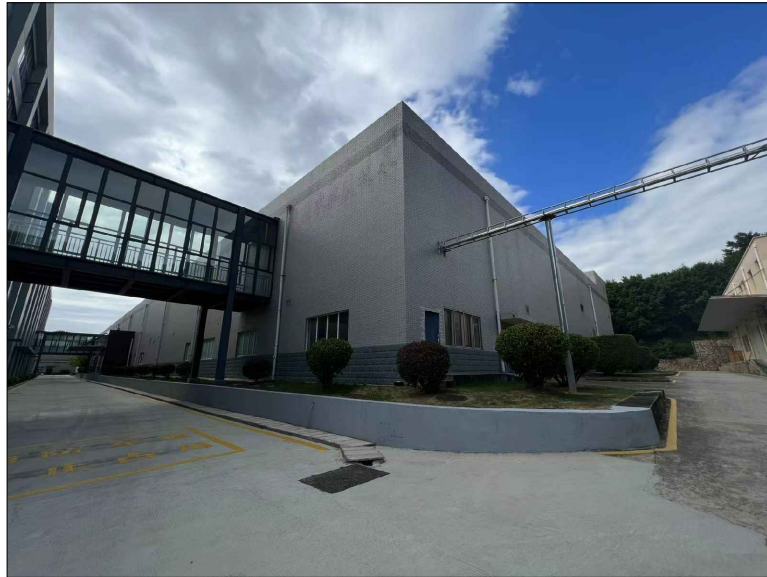
项目区现场照片1
