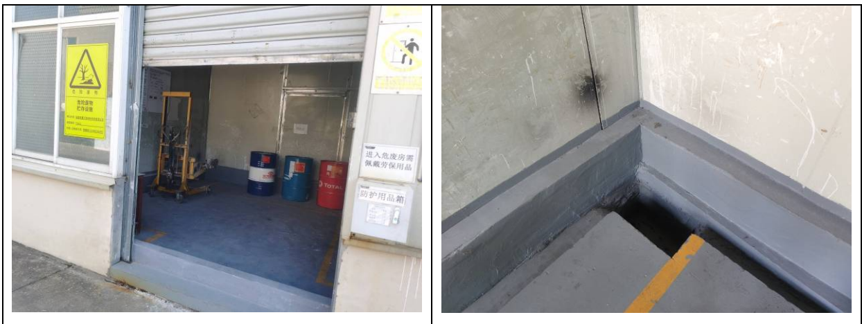
图 4.6-1 现有工程危废间地面防渗情况
