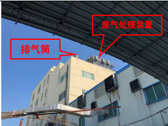
1#排气筒（对应 1 号、2 号压延生产线）
