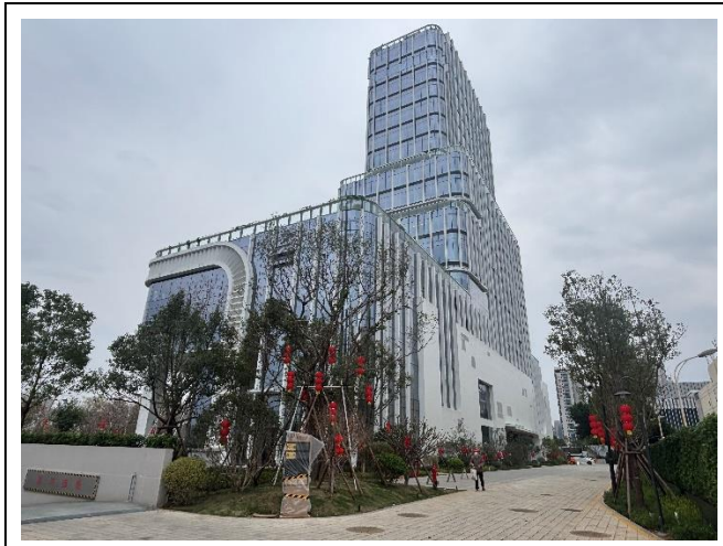
附件 09 项目区水土保持工程验收照片
