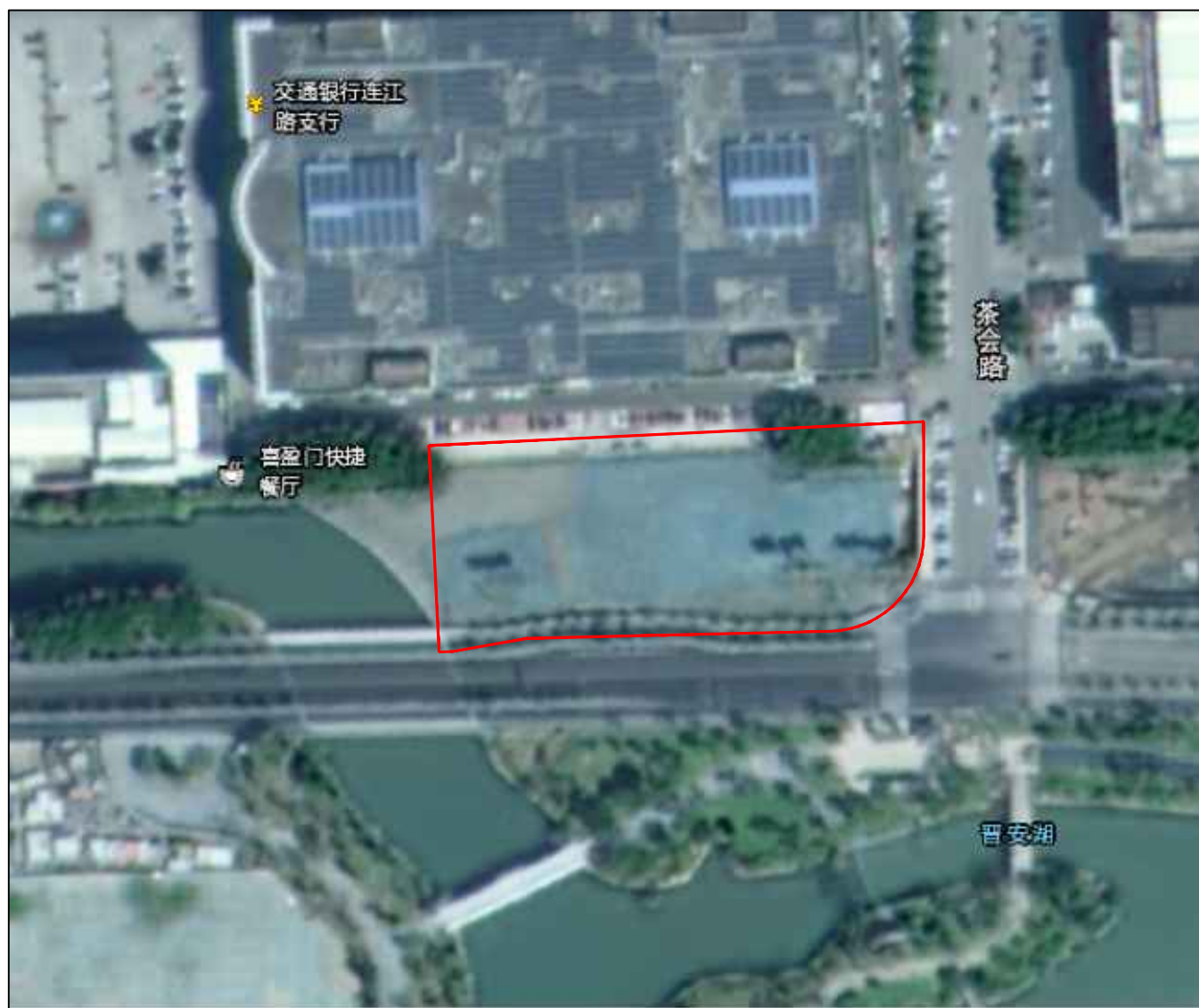
项目建设前卫星影像
